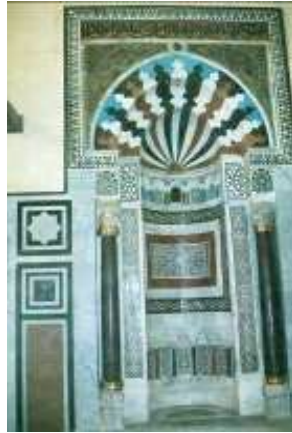
هـ- الترميم النهائى وعمل العمود الناقص والحلي النحاسية
