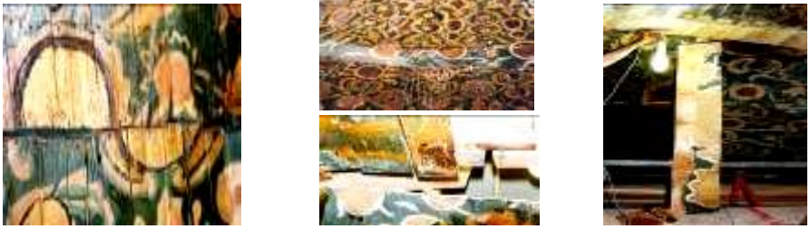
شكل رقم ٦ يبين انفصال الأخشاب عن جسم القبة ووجود ترميم خاطئ
