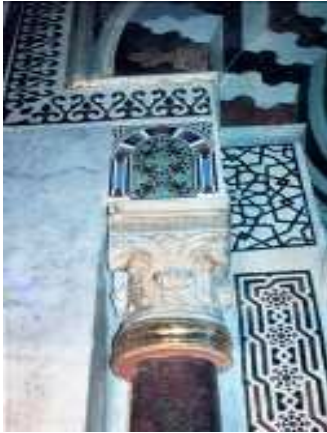
و- تاج العمود والجزء الزخرفى بعد الترميم
