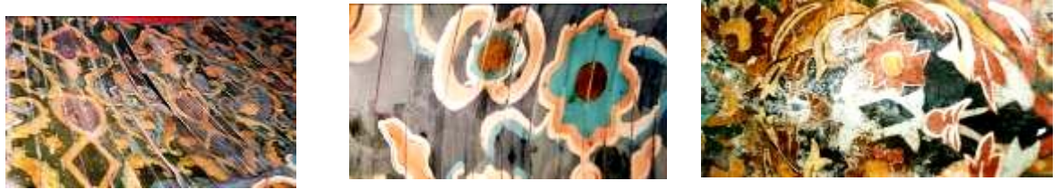
شكل رقم ٧ يوضح خروج الأخشاب عن مكانها الطبيعي في القبة وظهور مسامير التثبيت والزخرفة الخاطئة نتيجة الترميم والتركييب السابق
