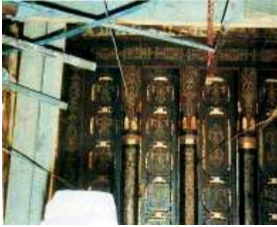
السقف أثناء الترميم
