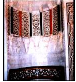
أ- الكتل الرخامية المحفورة بعد الترميم ب- الجزء العلوى للمحراب بعد الترميم والتقوية ج- الرخام المعشق بعد الترميم (فسيفساء)
